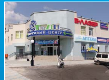
Торговый центр «В-Лазер» (г. Благовещенск)
