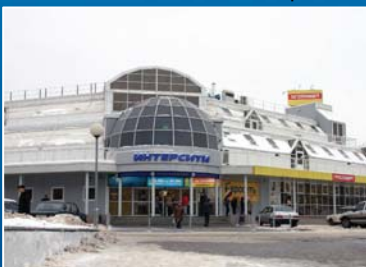
Торговый комплекс «Интерсити» (г. Тула)
